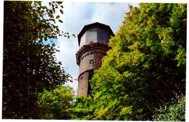
Abb. 43: Der Windmühlenturm in seinem grünem Umfeld der Parkanlage
