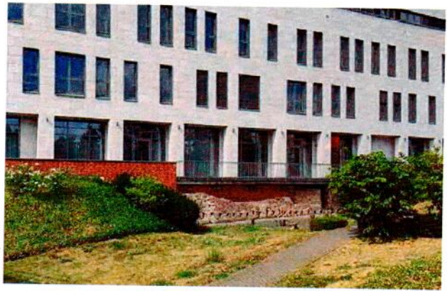
Abb. 51: Originalbestand und Rekonstruktion der Stadtmauer im Bereich des Kehlturns
