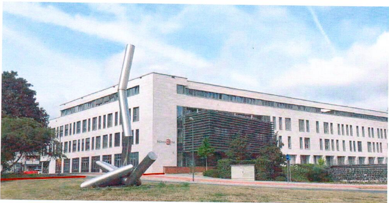
Abb. 52: Darstellung des Mauerverlaufes in Verlängerung der Rekonstruktion am Romaneum
