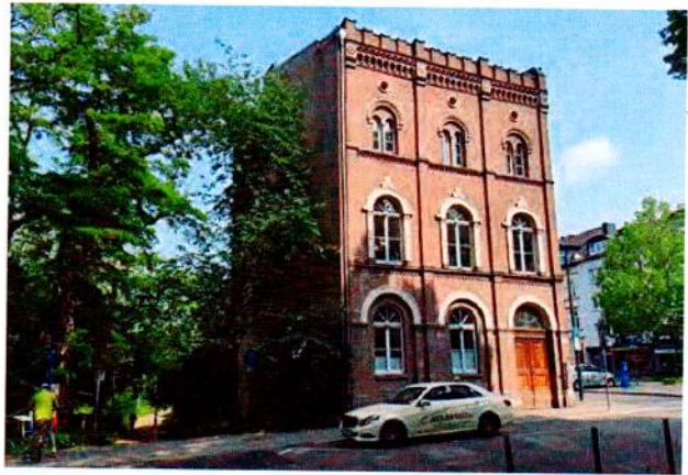
Abb. 30: Das denkmalgeschützte Wohnhaus genannt Tosetti-Haus
