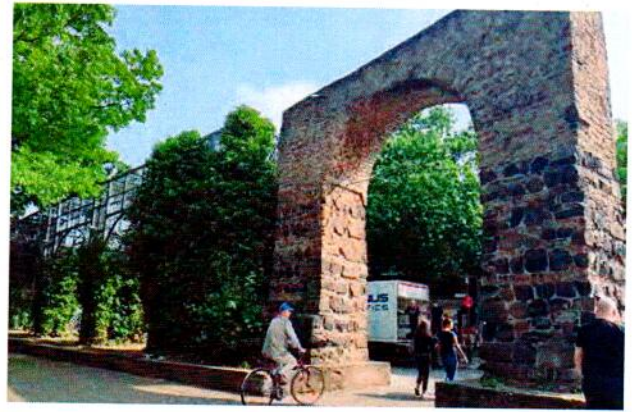
Abb. 26: Rekonstruktion eines Stützbogens des ehemaligen Wergangs mit angrenzendem Rankgerüst
