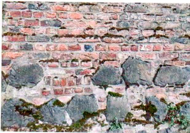
Abb. 04: Typischer Aufbau der Stadtmauer aus Basalt und Ziegelstein im 14. Jahrhundert
