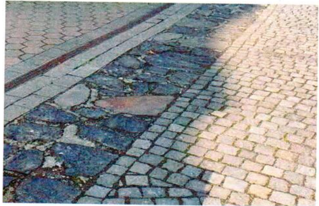
Abb. 67: Beispiel für eine Markierung des Stadtmauerverlaufes aus Fundmaterialien
