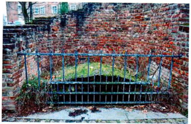
Abb. 70: Halbturm Wierstraetweg, Aufmauerung auf Originalbefunden
